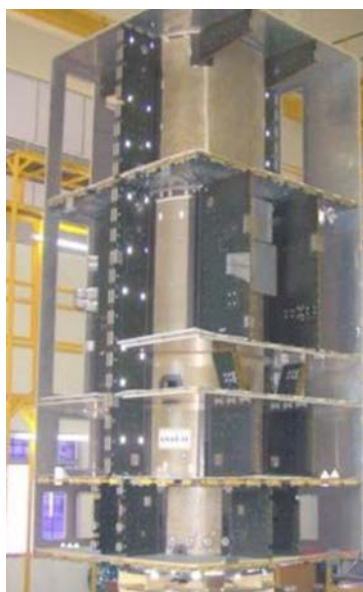
Рис. 4.25. Платформа I-6000 в процессе сборки
